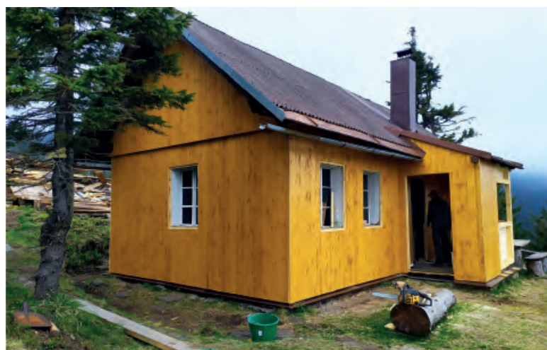
Dokončování rekonstrukce chaty Kvedlena. Foto: Rostislav Blaho.
