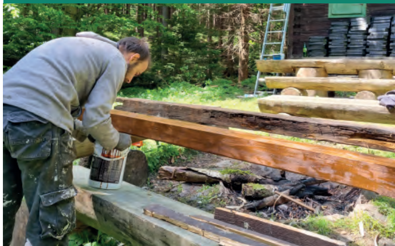
Oprava trámů na chatě Podzámecká. Foto: Archiv ALSOL.
