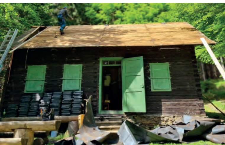
Oprava střechy na chatě Podzámecká. Foto: Archiv ALSOL.
