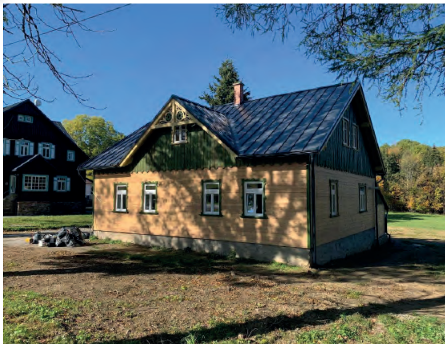
Nově zrekonstruovaná hájenka na polesí Rejvíz. Foto: archiv ALSOL.
