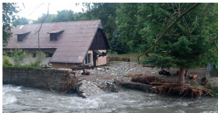
Budova polesí po částečném opadnutí vody. Foto: Bc. Jan Ťulpík
