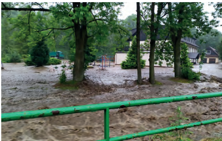
Areál a budova polesí Domašov pod vodou. Foto: Bc. Jan Ťulpík
